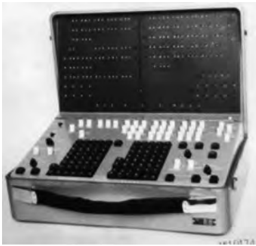
Рис. 2.4.14. Пульт контроля и управления (ПКУ)
