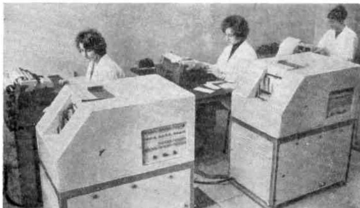
Рис. 6. Зал подготовки перфокарт на устройствах типа УПП1М
