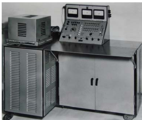
Технологический стенд проверки запоминающих ферритовых матриц оперативной памяти ЭВМ «Минск-2»
