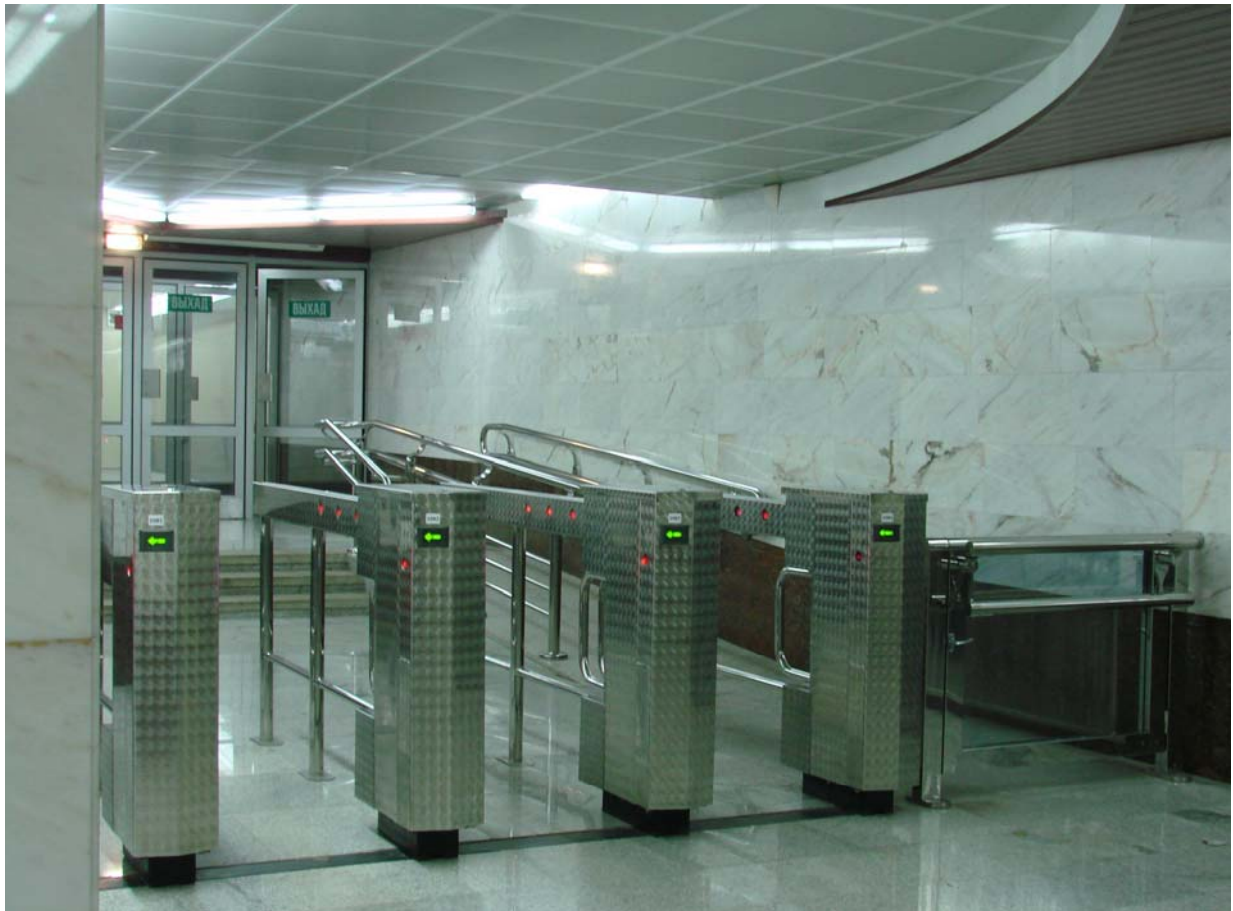
Линейка выходных турникетов ПКА-К на станции «Борисовский тракт» Минского метрополитена
