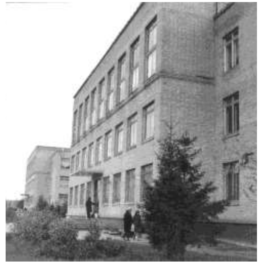
Рис. 27. Первые производственные здания в Спутнике: «школа швейников (корпус "Ш")» и «школа металлистов (корпус "М")».
